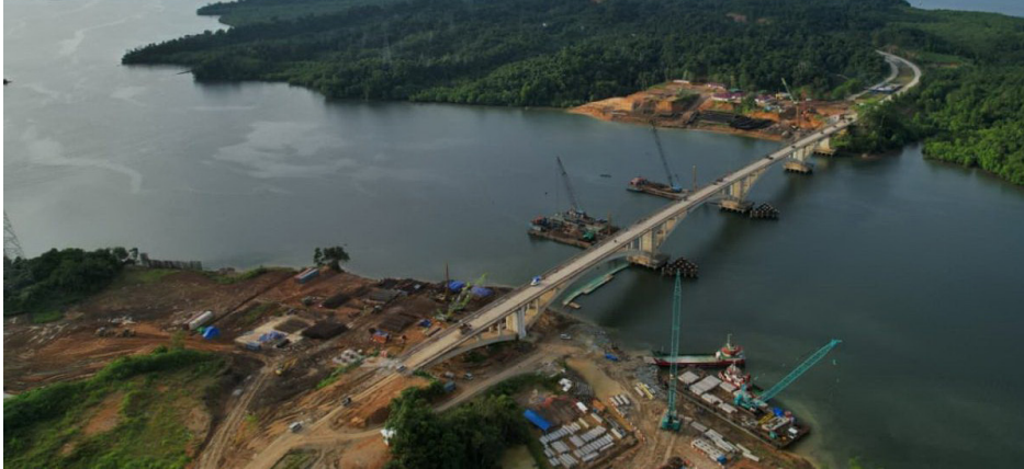
Pembangunan Jembatan Duplikasi Bentang Pendek Pulau Balang sebagai upaya peningkatan konektivitas ke IKN.
