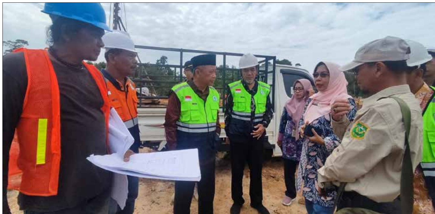
Pj Sekda Berau, Agus Wahyudi saat meninjau proses pembangunan TPI Tanjung Batu.
